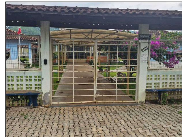
Imagem do Local de Instalação da Malha
