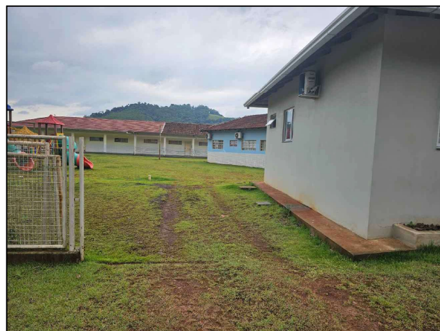
Imagem do Local de Instalação
